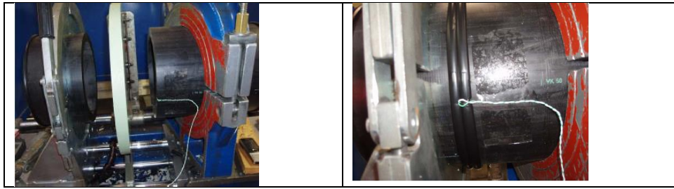
Figura 2 Soldadura de tubos a tope (PLASFLOW)
