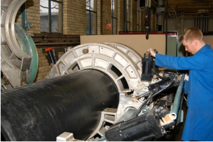
FIG. 1 SOLDADURA DE TUBOS DE PE POR BF
